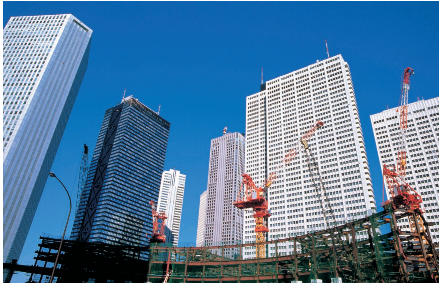
高層ビルディング High-rise building
