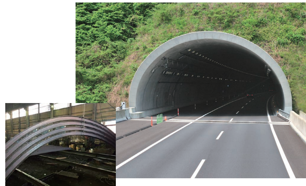
トンネル用支保工 Tunnel support
