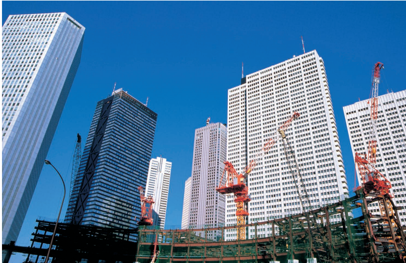
高層ビルディング High-rise building
