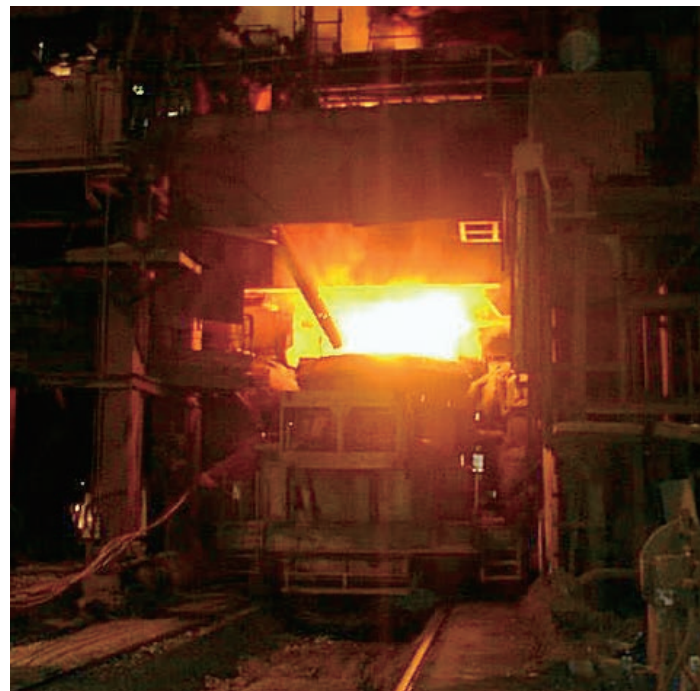
電気炉 Electric furnace
